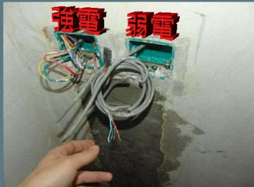
圖一：在水電工程中強電與弱電就能明顯看出線材配置的不同處
