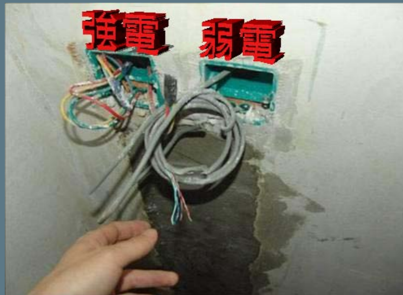
图一：在水电工程中强电与弱电就能明显看出线材配置的不同处
