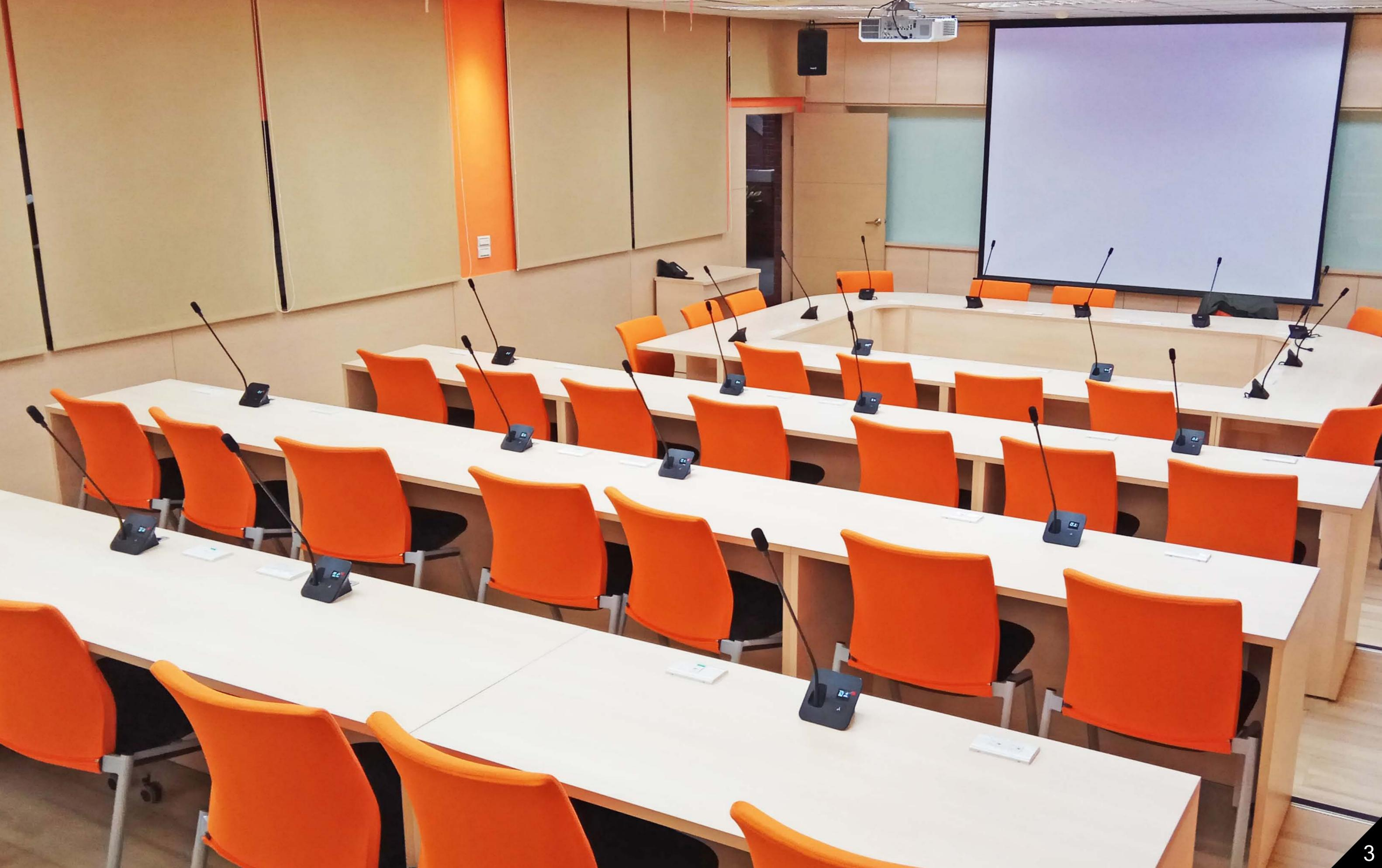
FUN系列每个单体皆具备OLED，可显示N(一般)/F(排队)/O(轮替)/C(主席)四种会议发言模式及单体ID码。另外，单体上的OLED也可显示会议单体目前工作电压(5V~24V)及低电压的警告，这对安装者及管理者来说，可以快速的知道及排除故障的单体，维持会议的进行。另外，精准的智能声控启动功能，可精确判断出发言者的声音，进而自动启动麦克风，不会因为扩音喇叭的声音及鼓掌声，造成错误开启麦克风，也可在发言结束后，自动关闭麦克风，达到自动化的会议需求。且FUN单体的另一个特点是自由的会议身份设定，可依据会议的需求，将列席麦克风设定为主席权限，此时列席单元则变成副主席发言单元。可依据会议的需求，将列席麦克风设定为主席权限，脱离会议秩序模式的限制，使会议可弹性地进行。
