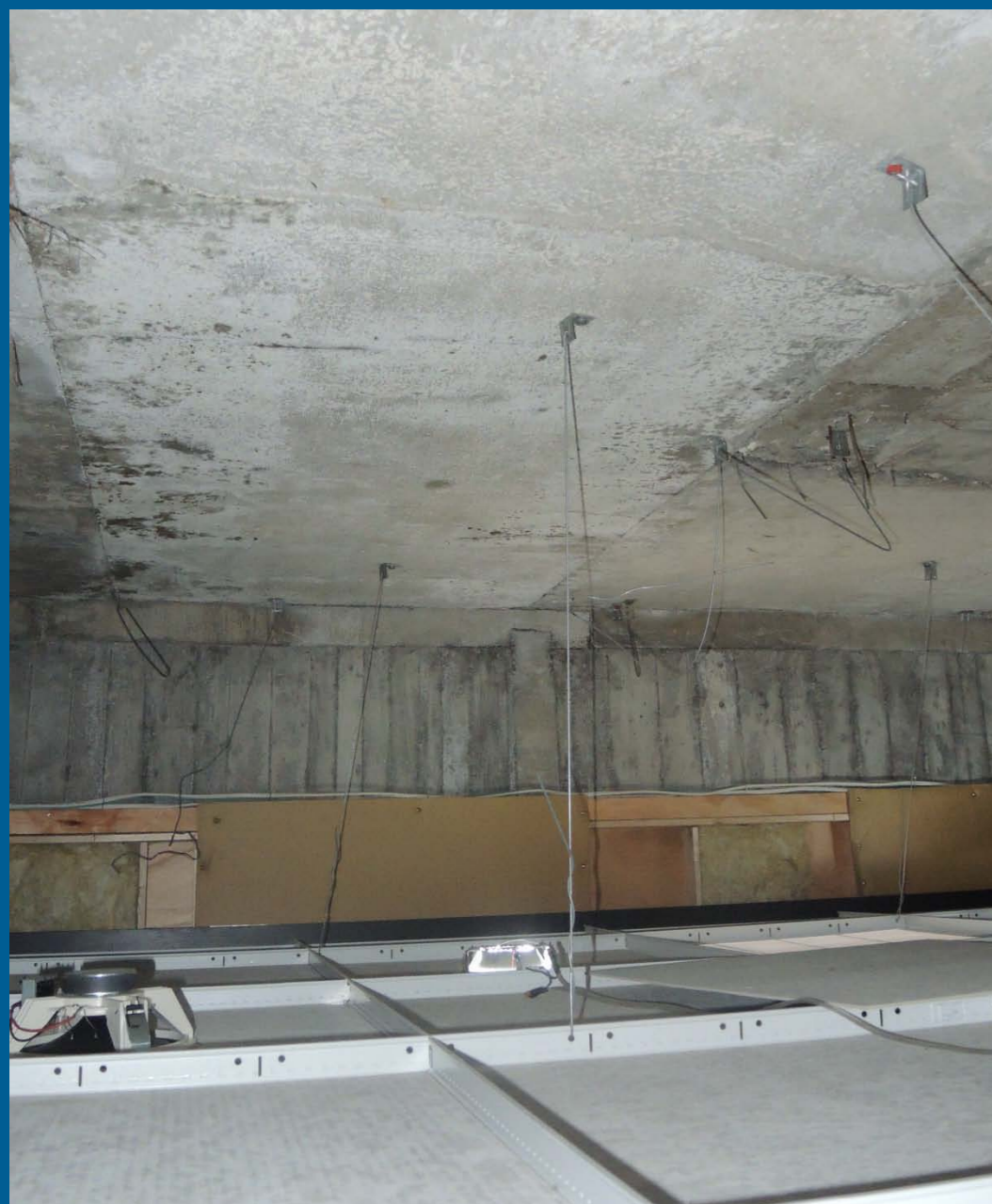
图三：“吊筋””铝框”实际安装照片
