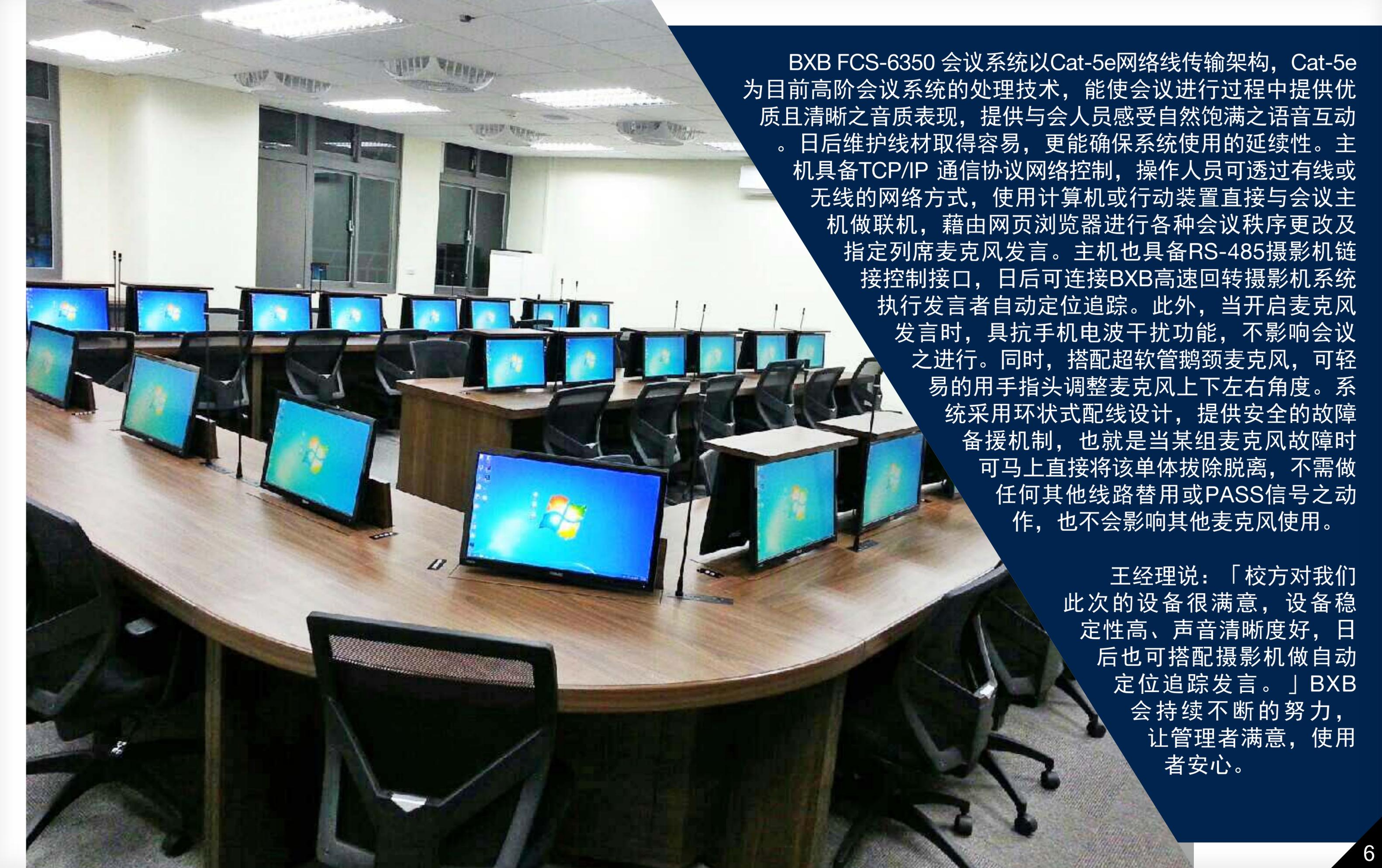
BXB FCS-6350 会议系统以Cat-5e网络线传输架构，Cat-5e为目前高阶会议系统的处理技术，能使会议进行过程中提供优质且清晰之音质表现，提供与会人员感受自然饱满之语音互动。日后维护线材取得容易，更能确保系统使用的延续性。主机具备TCP/IP 通信协议网络控制，操作人员可透过有线或无线的网络方式，使用计算机或行动装置直接与会议主机做联机，藉由网页浏览器进行各种会议秩序更改及指定列席麦克风发言。主机也具备RS-485摄影机链接控制接口，日后可连接BXB高速回转摄影机系统执行发言者自动定位追踪。此外，当开启麦克风发言时，具抗手机电波干扰功能，不影响会议之进行。同时，搭配超软管鹅颈麦克风，可轻易的用手指头调整麦克风上下左右角度。系统采用环状式配线设计，提供安全的故障备援机制，也就是当某组麦克风故障时可马上直接将该单体拔除脱离，不需做任何其他线路替用或PASS信号之动作，也不会影响其他麦克风使用。
