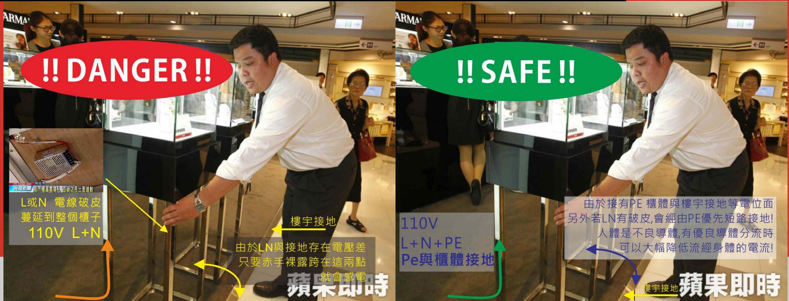
我們可以看到中間下方，磁磚與專櫃間有一片金屬踢腳板，這個金屬片會被與樓宇樓板進行鎖合，等於是一個接地電位面。而接入櫃子的電源是只有黑白L+N的電源線，卻沒有PE保護接地，當電線穿進不銹鋼架，L+N線線皮可能會被戳破造成櫃體導電，此時如果碰觸櫃體，還穿著膠鞋不接觸到踢腳板基本沒有問題，但是如果一個肢體碰觸地板踢腳板，一手碰櫃體，就形成導通路徑！
